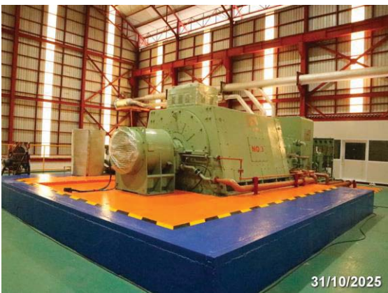
รูปที่ 3-25 เครื่องกำเนิดไฟฟ้าอยู่ในอาคารปิด
