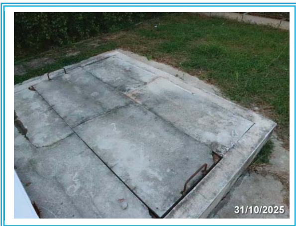
รูปที่ 3-18 ระบบบำบัดน้ำเสียแบบพอเกรอะ-พอซึม
