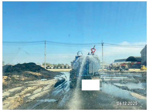
รูปที่ 3-14 ฉีดพรมน้ำเส้นทางขนส่งเถ้า
