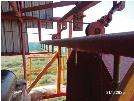
รูปที่ 3-6 ติดตั้งสปริงเกอร์ตลอดแนวสะพานยาง
